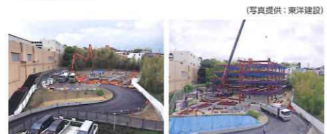
基礎躯体工事 鉄骨建方工事
